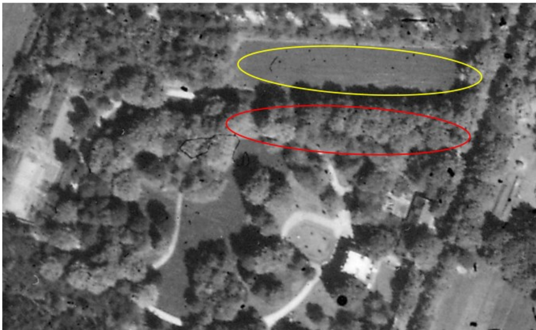
Figuur 3.6: Detail uit de luchtfoto van 1936. Zichtbaar is voornamelijk de padenstructuur aan de achterzijde van de woning. De entree is ook hier al lusvormig om de dienstwoningen heen. De projectlocatie is aan de noordzijde van het perceel gelegen. In 1936 is dit nog duidelijk een gras- of akkerland, duidelijk begrensd van de landschapstuin. De aanplant ten zuiden van het grasland (rood) is een laan die nu nog aanwezig is. In geel (globaal) de projectlocatie.
