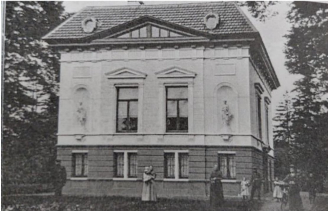
Figuur 3.4: Huize Treeswijk, ná de verbouwing door baron [redacted]. Meest in het oog springend is het verdwijnen van de naam van het huis en het terugbrengen van het aantal verdiepingen van drie naar twee. In de periode hierna werden aan beide zijde nieuwe aanbouwen gebouwd.
