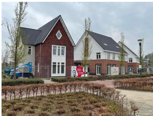
Nieuwe woningen op het perceel Bleek 15
