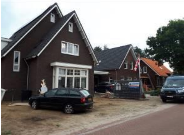
De bouw van de woningen in De Boslaantjes en aan de Heistraat is in volle gang
