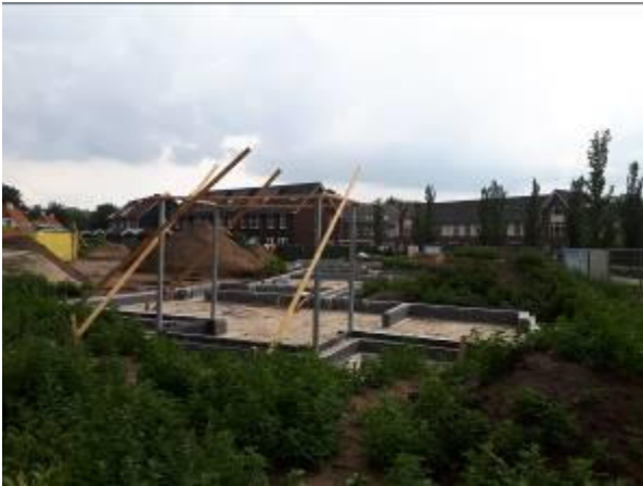
Woningbouw op de hoek van de Bleeck en de Heistraat is gestart
