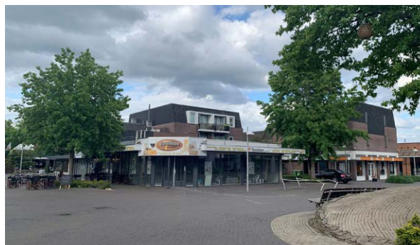
Middenblok met lagere delen in de bebouwing
